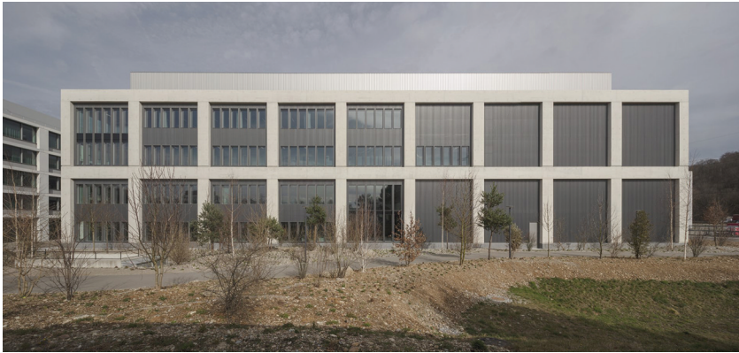
Abbildung 1: Klare und einheitliche Fassade: das Projekt LSL der F. Hoffmann-La Roche AG (Quelle aller Abbildungen: janbitter.de).
